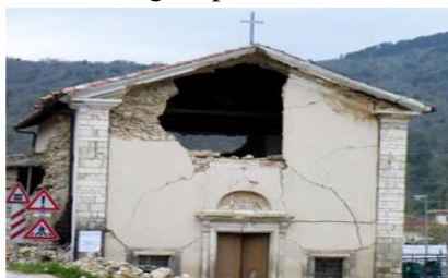
Figura 5. Estrutura atingida por mecanismo de flexão horizontal de parede e modelo cinemático.
